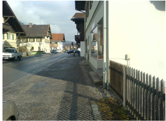
Neue Hauptstraße mit Straßenbegleitfläche
