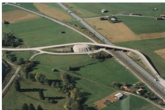
Stand 1996: Behelfsbrücke über Bahn und B 2
